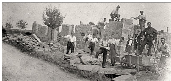
Maurerarbeiten für den Turnhallenbau - leider etwas unscharf.
