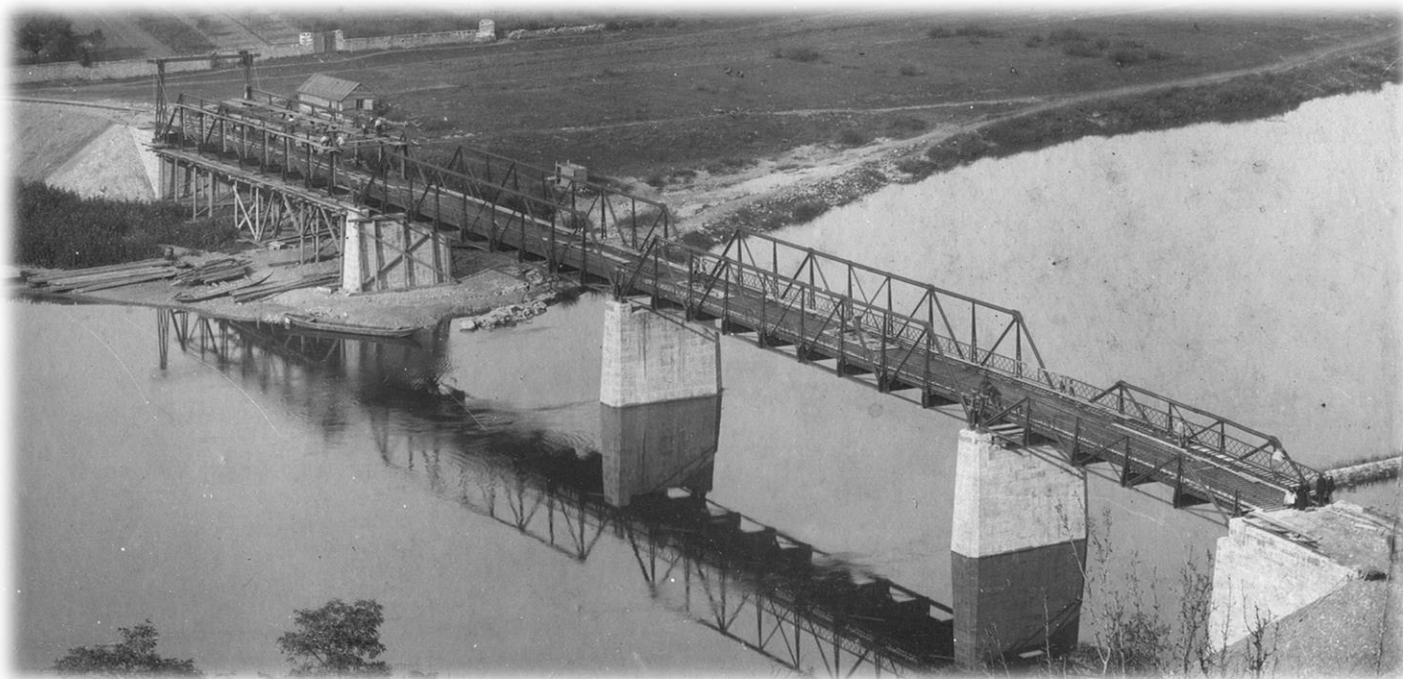
Die Segnitzer Brücke während der Bauzeit im Jahr 1893
