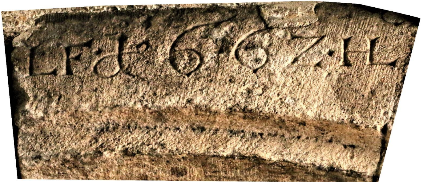
Der Abschlussstein am Torbogen zum Keller des Fachwerkhauses im Bräuhof trägt die Initialen der Bauherren.
