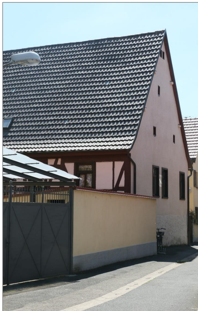
Haus Nr. 108/Vordere Raingasse 3
