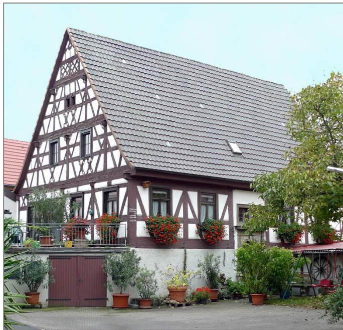
Das ehemalige Gasthaus Zum weißen Lamm im Bräuhof, 2013 noch in alten Farben.
