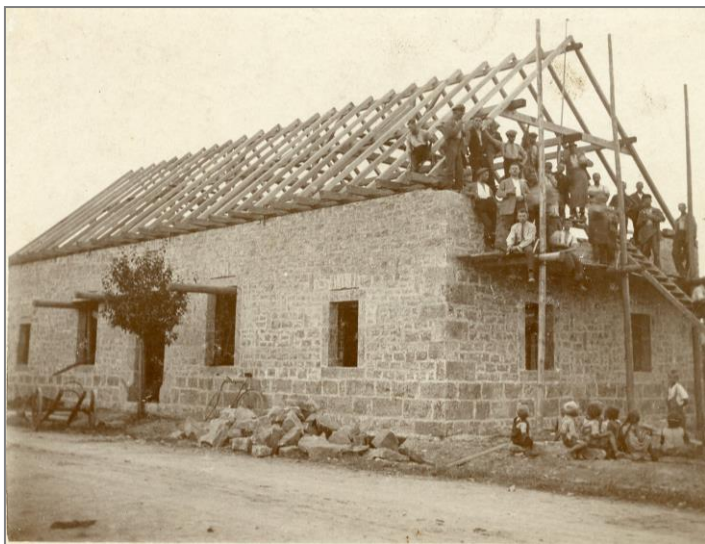
Richtfest an der alten Turnhalle an der Sulzfelder Straße am 8. September 1928.
