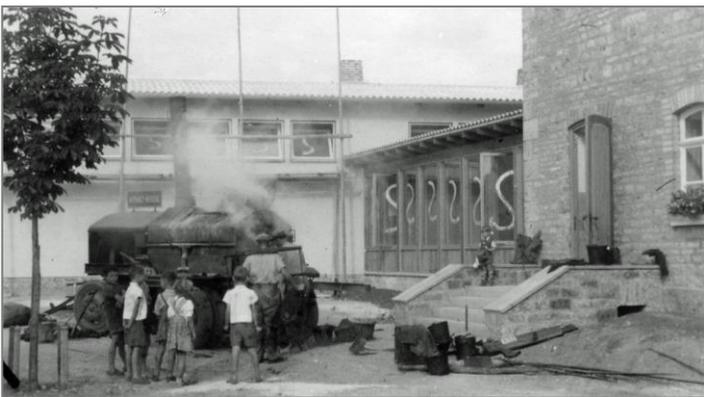
Asphalt für die Böden in den Klassenzimmern.
