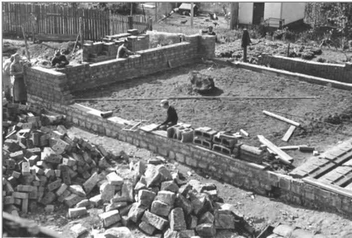
Ab 1. September 1955, Aushub des Baugrundes, anschließend Maurerarbeiten durch die Firma Schleicher, Obernbreit.
