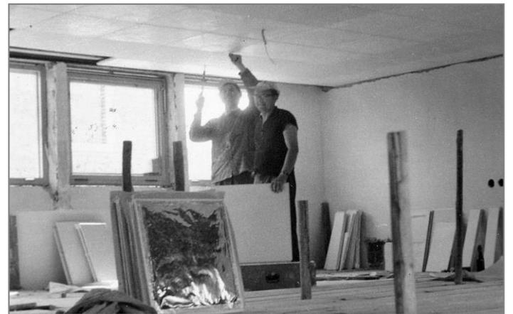
Knauf, schallgedämpfte Decken-Gipsplatten.
