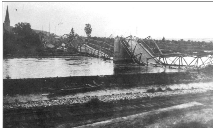
Die Segnitzer Brücke nach der Sprengung am 5. April 1945.
