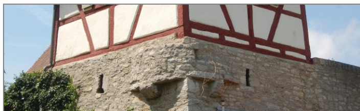
Der Maueraufsatz an der südöstlichen Ecke der Kirchenburg.
