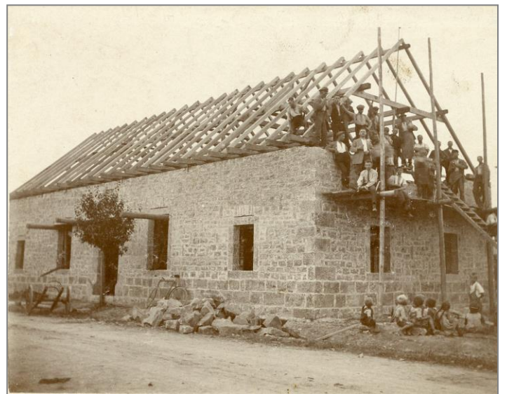
Richtfest am 8. September 1928.
