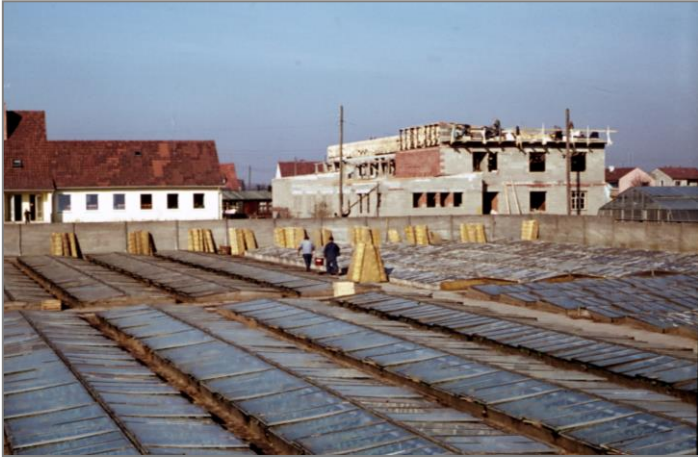
Der Rohbau der Turnhalle. Im Vordergrund Mistbeetkästen der Gärtnerei Krackhardt, links das Kindergartengebäude aus dem Jahr 1959.
