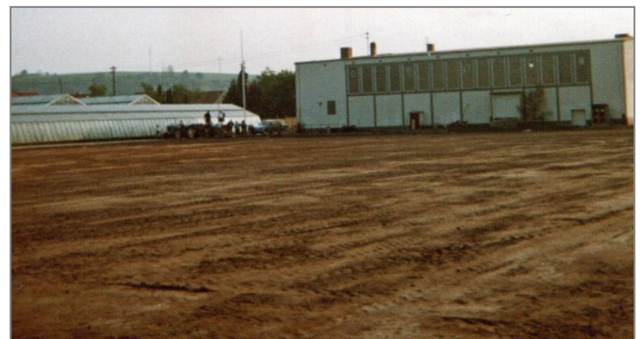
1971, Sportplatzbau an der Jahnstraße
