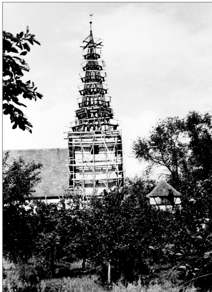
Die Kirchturmrenovierung im Jahr 1960.
