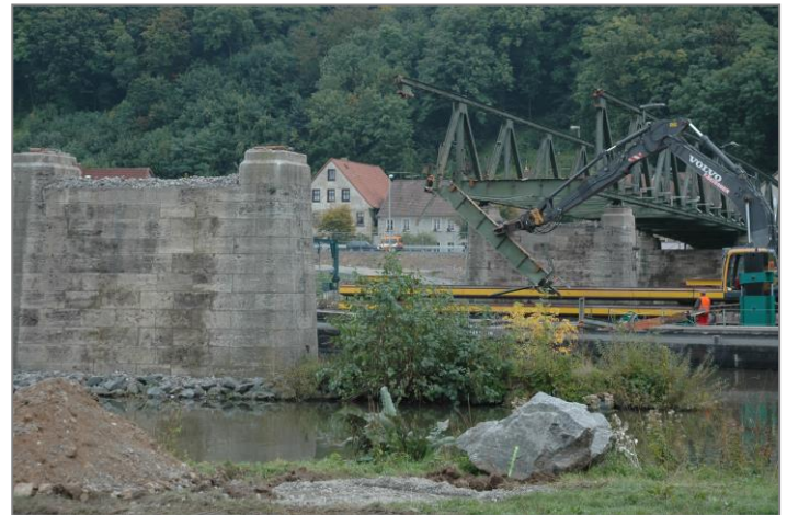
Abbruch der alten Brücke im September 2010
