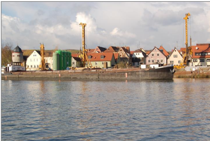
Die Baustelle an der Mainlände im November 2005. Im Vordergrund ein Frachtschiff für den Abtransport des kontaminierten Bodens.
