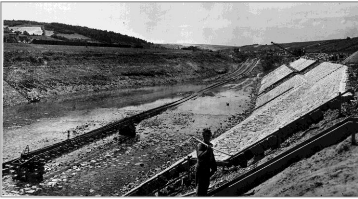
11. Juli 1951: Baugrube des Unterkanals mit der landseitigen Pflasterböschung.
