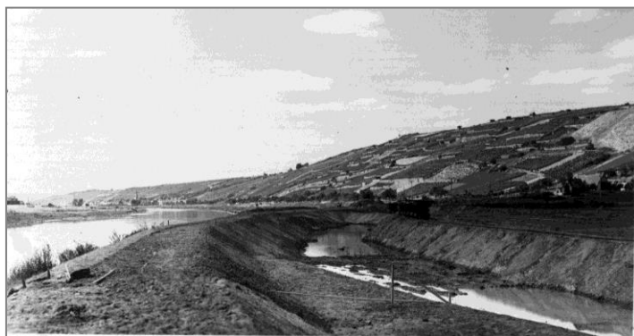
18. Juli 1950: Aushub am Unterkanal. Im Hintergrund Frickenhausen.
