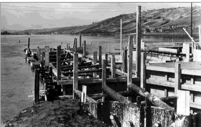
3. April 1952: Baugrube des Unterhauptes beim Höchststand des Hochwassers. Die Grube wurde nicht überspült.
