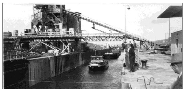
November 1953: Die Schleuse von Oberstrom gesehen. Links die Wehrbaustelle, Rechts das Schleusensteuerhaus.
