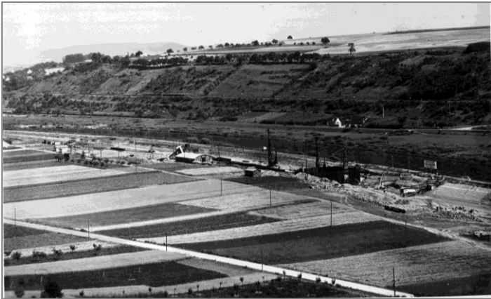
11. Juli 1951: Blick von der rechten Anhöhe auf die Schleusenbaugrube von Unter- nach Oberstrom.
