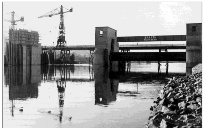
25. November 1953: Wehröffnung „R“ und „M“ von Oberstrom gesehen.
