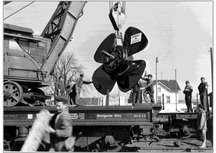
31. März 1955: Turbinenmontage, entladen des Laufrades.
