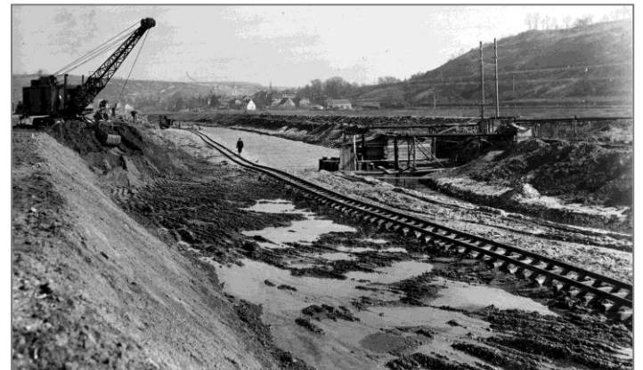
7. März 1951: Blick von der Stelle des künftigen Unterhauptes gegen den Oberkanal.
