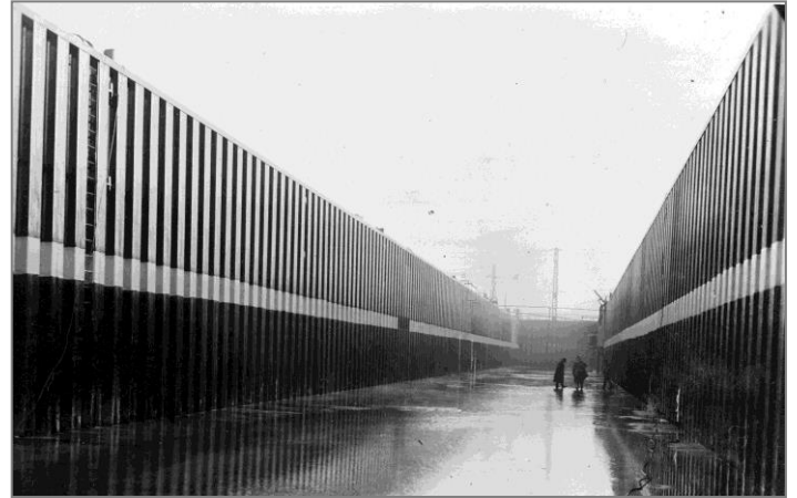
6. Dezember 1952: Blick in die große Schleusenammer vom Unterhaupt nach Oberhaupt vor der Flutung.
