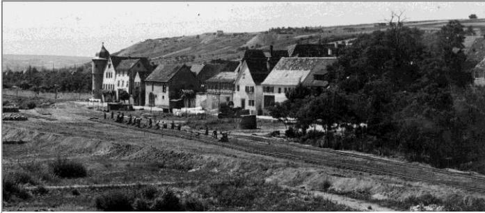
Gleisbauarbeiten auf der Segnitzer Mainlände.
