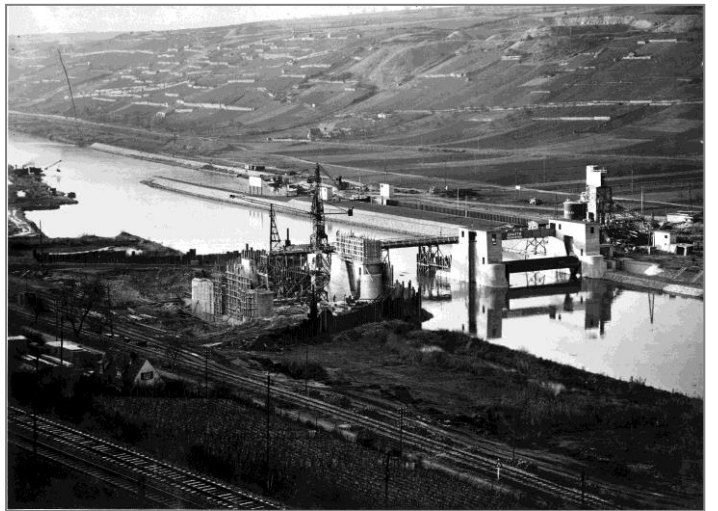
25. November 1953: Blick vom Hang am linken Ufer stromab auf die Baustelle.
