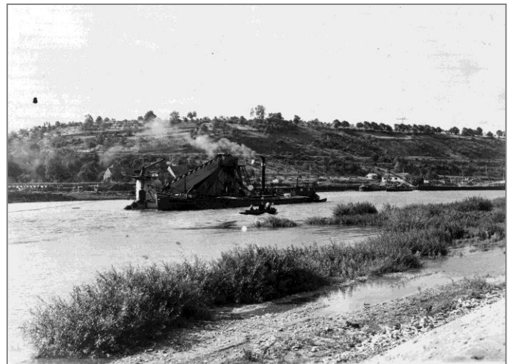
22. September 1954: Eimerkettenschwimmbagger „Jupiter“ bei der Ausbaggerung der Großschifffahrtsrinne unterhalb der Segnitzer Brücke.
