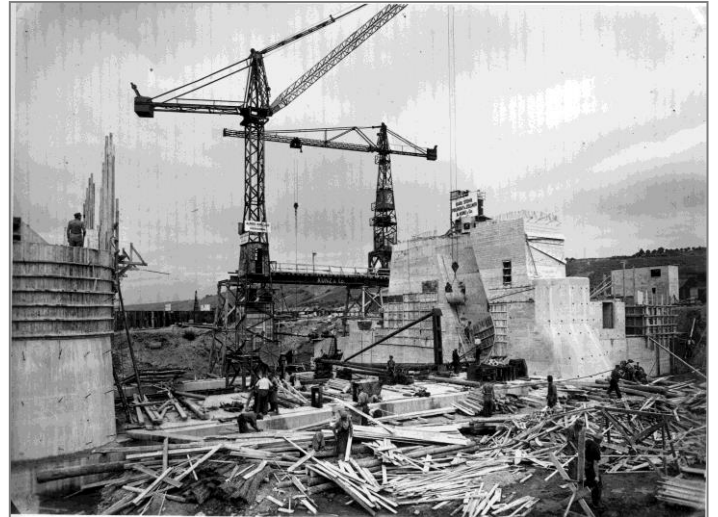
7. Juli 1953: Die Wehrbaugrube „R“ von Oberstrom gesehen.
