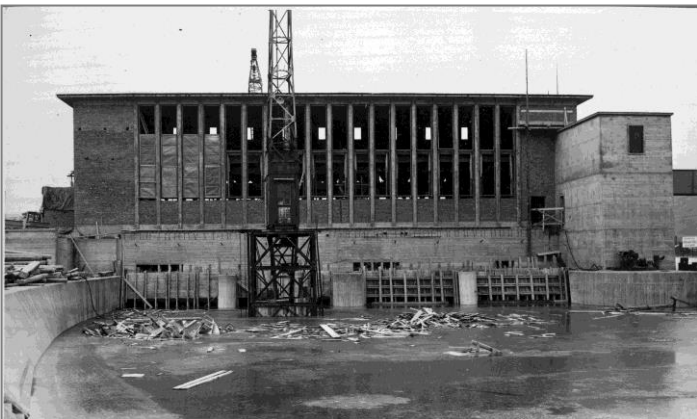
18. Januar 1955: Krafthaus von Oberstrom.
