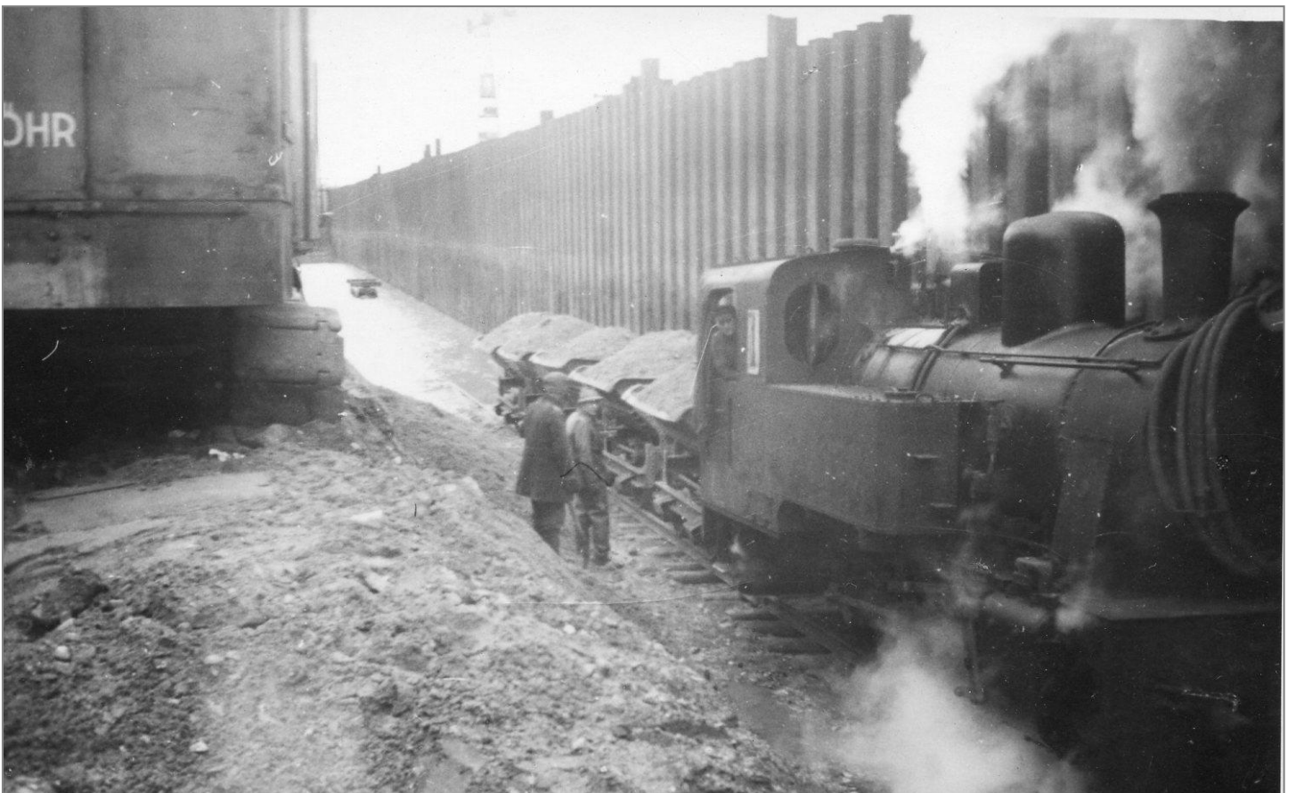
Verladen von Aushub vor der Spundwand der Marktbreiter Staustufe. Die Segnitzer Mainländerbahn war mit Dampflokks und Wagen mit einem Fassungsvermögen von 5 Kubikmetern Erdmassen ausgerüstet. Die Züge verkehrten auf schwerem Geleis mit 90er Spur.
