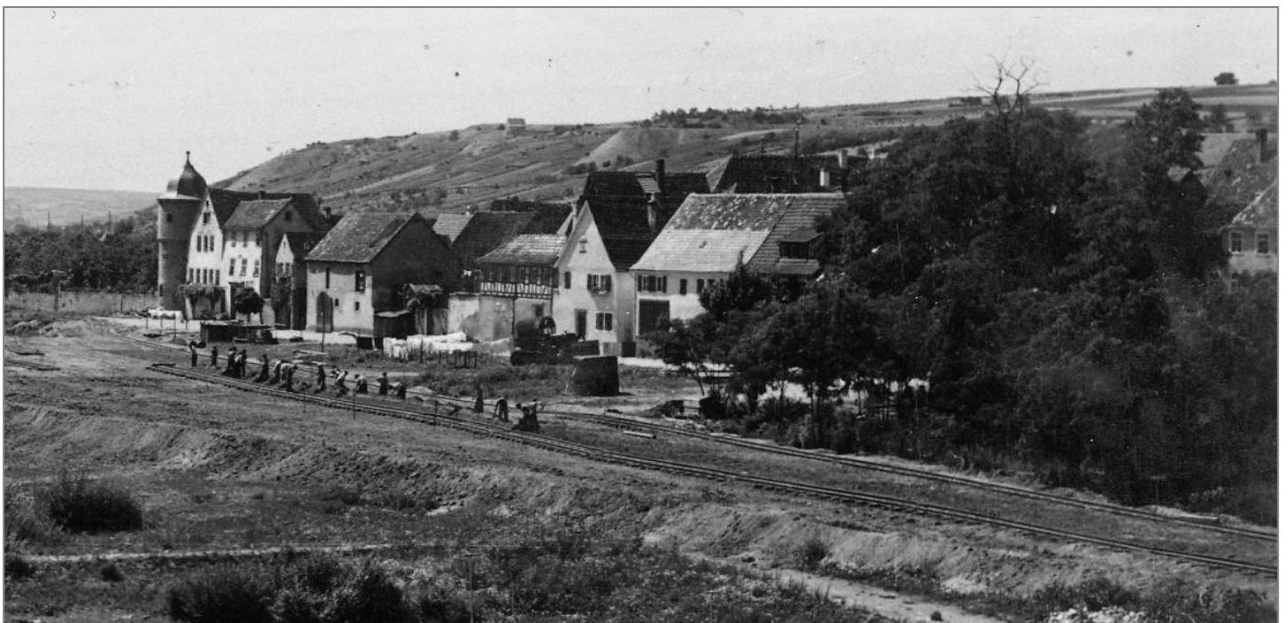
Geleisbau vor den Toren von Segnitz. Während der Tiefbauarbeiten an der Staustufe Marktbreit verkehrte eine Transportbahn am Mainufer entlang zwischen der Baustelle und dem Mainvorland oberhalb von Marktbreit.
