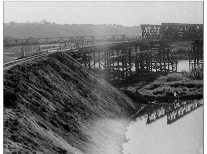
Um die Erdmassen über den Main zu führen musste 200 m oberhalb der Segnitzer Brücke eine Transportbrücke errichtet werden. Zum Einsatz kam hier ein Pionierbrückengerät System Roth-Wagner. Bahnstrecke und Brücke waren bis Mitte 1954 in Betrieb.
