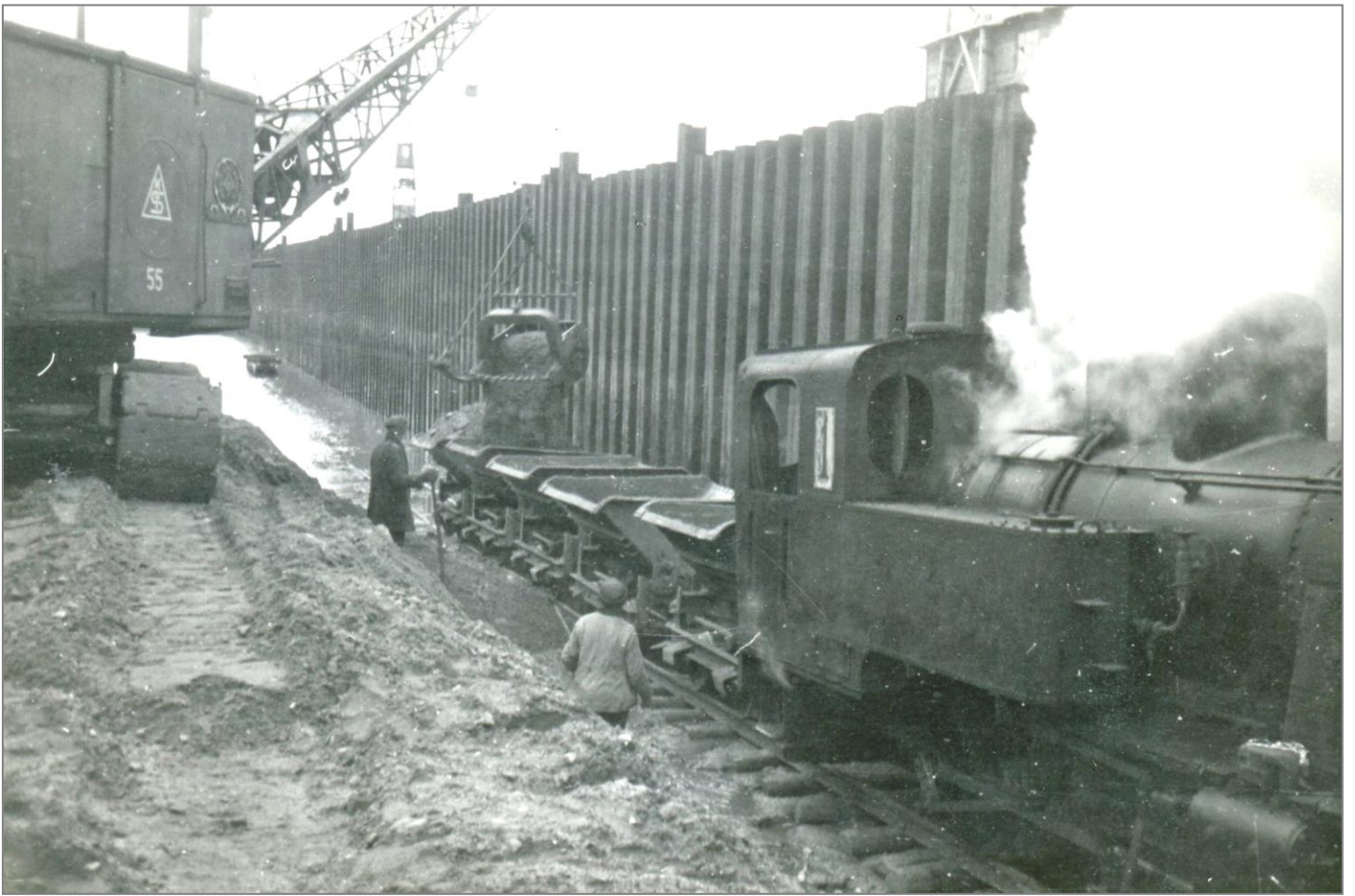
Verladen von Aushub vor der Spundwand der Marktbreiter Staustufe. Die Segnitzer Mainländerbahn war mit Dampflokks und Wagen mit einem Fassungsvermögen von 5 Kubikmetern Erdmassen ausgerüstet. Die Züge verkehrten auf schwerem Geleis mit 90er Spur.
