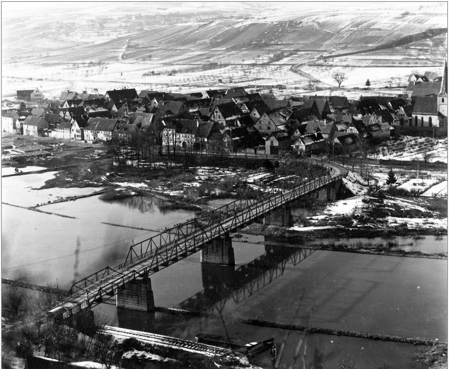
Endpunkt der Marktbreiter Mainländebahn an der Segnitzer Brücke (Bildmitte unten). Nach den Wünschen der Marktsteffer Unternehmer sollte mit der Fortsetzung dieser Strecke die Verbindung zum Marktbreiter Bahnhof hergestellt werden.
