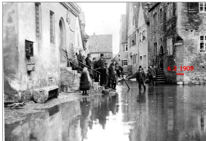
Februar 1909 als das Wasser bereits zum Teil abgelaufen war und „nur“ noch bis zum Rathaus reichte. Am „markgräflichen Amtshaus“ ist die spätere Hochwassermarke mit Stand 6.2.1909 rot hervorgehoben.
