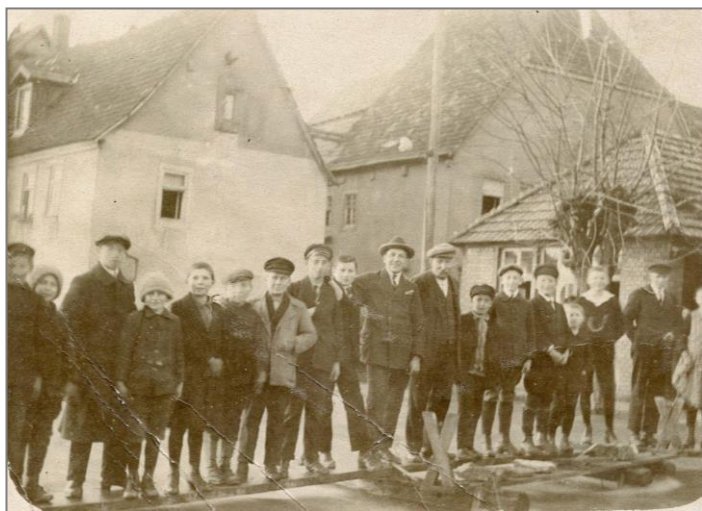
Ein Steg in der Mainstraße diente im Januar 1920 als provisorische Verbindung zur Brücke. Als das Bild entstand, war das Schlimmste wohl schon überstanden.
