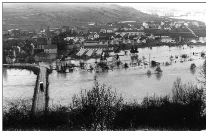
Hochwasser Februar 1970 (Foto: Schönherr).
