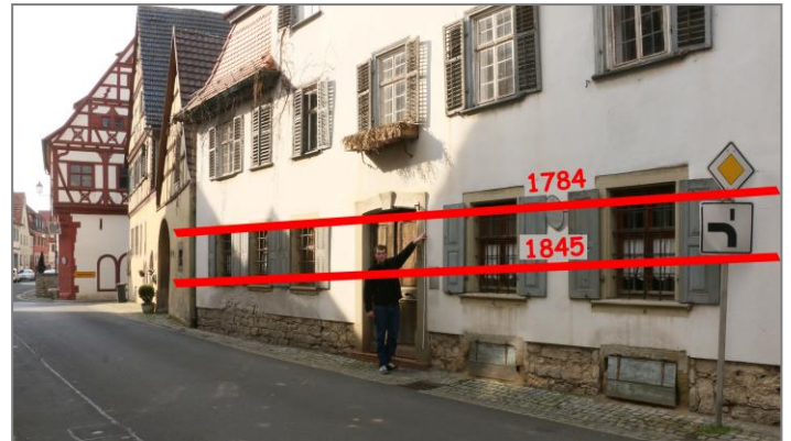
Die Hochwässer von 1784 und 1845 in der Hans-Kesenbrodstraße Ost in Segnitz.
