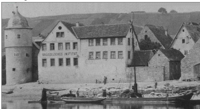
Ausschnitt aus dem Panoramafoto anlässlich der Fertigstellung der ersten Segnitzer Brücke im Jahr 1893. Der Turm ist noch mit einem kleinen Erdgeschossfenster ausgestattet. Rechts daneben ist die Verbindung der ehemaligen Dorfmauer mit dem Turm zu erkennen. Die Beschriftung am Nebengebäude erinnert indessen an das Brüsselsche Handels- und Erziehungs Institut
