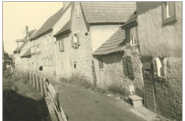
Am Graben mit der Dorfmauer und den aufgesetzten Gebäuden
