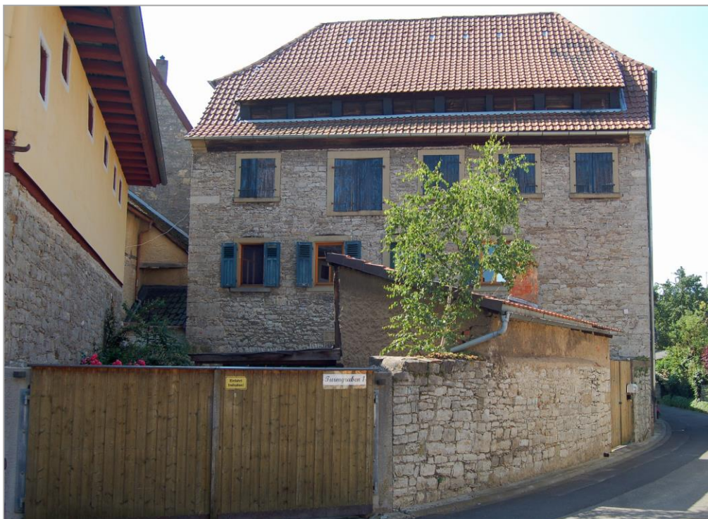
Die ehemalige Rotgerberei am Turmgraben 1. Die Belüftungsgaube auf dem Dach lassen noch immer die frühere Nutzung des Gebäudes erkennen. Im Hintergrund erscheint der Giebel des Krönleinhauses, links die dazugehörige Scheune
