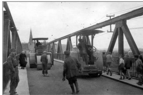
Nach dem Teeren der Fahrbahn konnten die amtlichen Belastungstests am 29. April 1949 durchgeführt werden. Zwei Walzen mit insgesamt 22 Tonnen Gewicht prüften den auf 16 Tonnen Tragkraft ausgelegten Mainübergang.
