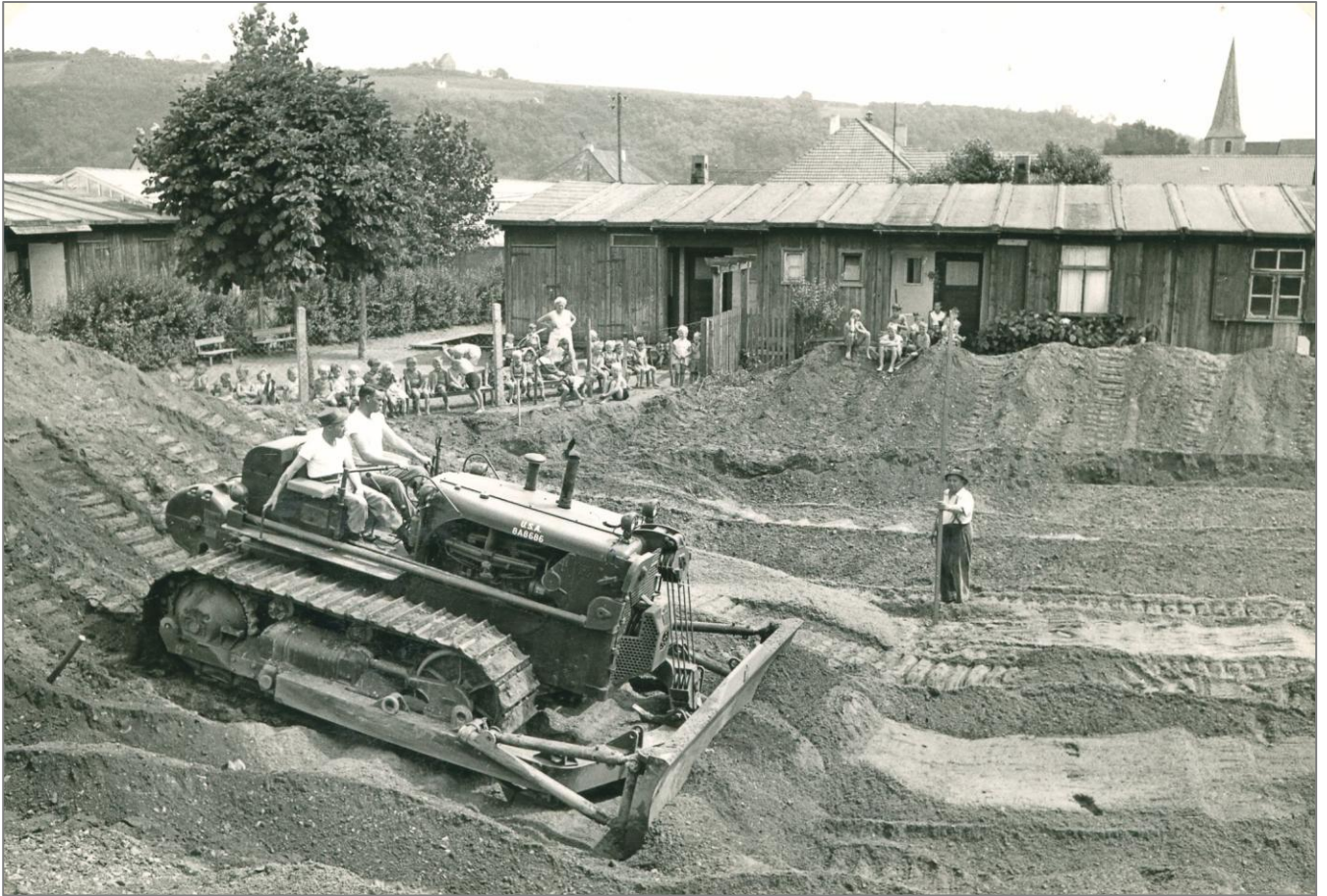
Bild: Bau des Kindergartens im Jahr 1959. Im Hintergrund eine Baracke der „Düsseldorfer Siedlung“.
