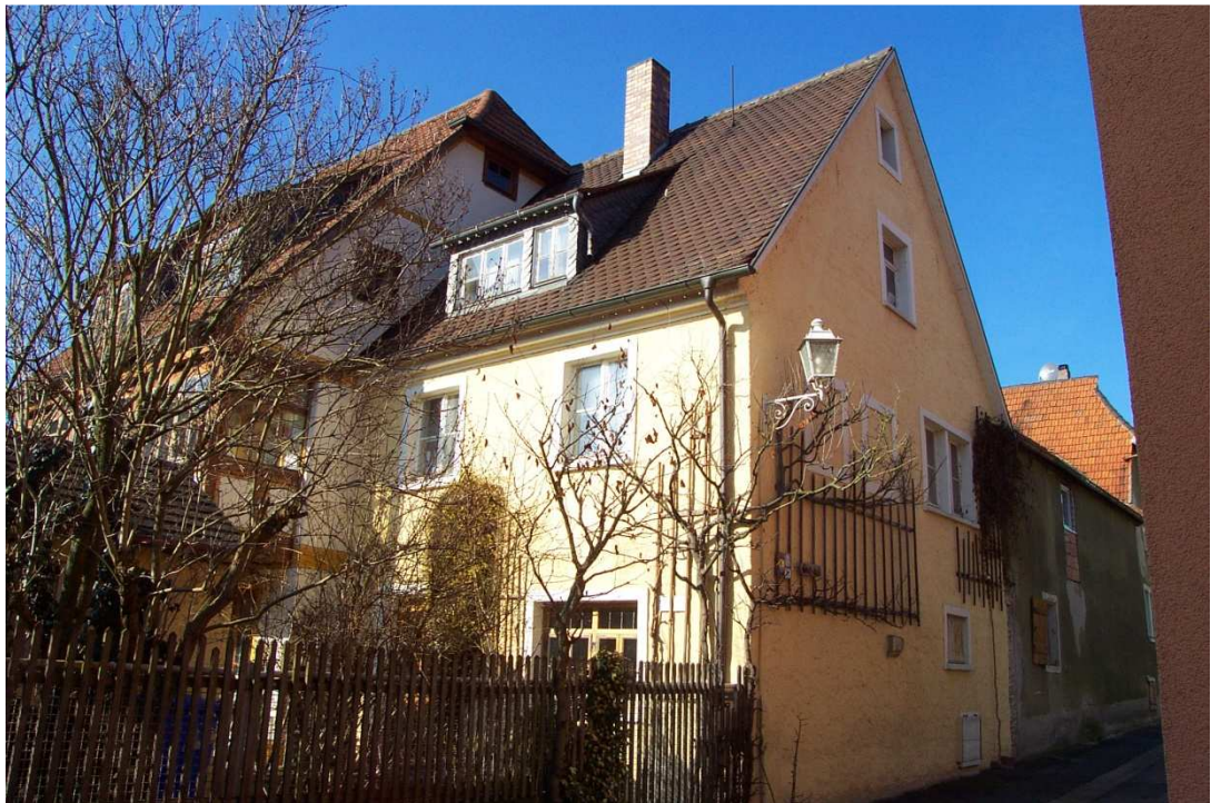
Wohnhäuser Brückengasse 2 und Nachbarhaus
