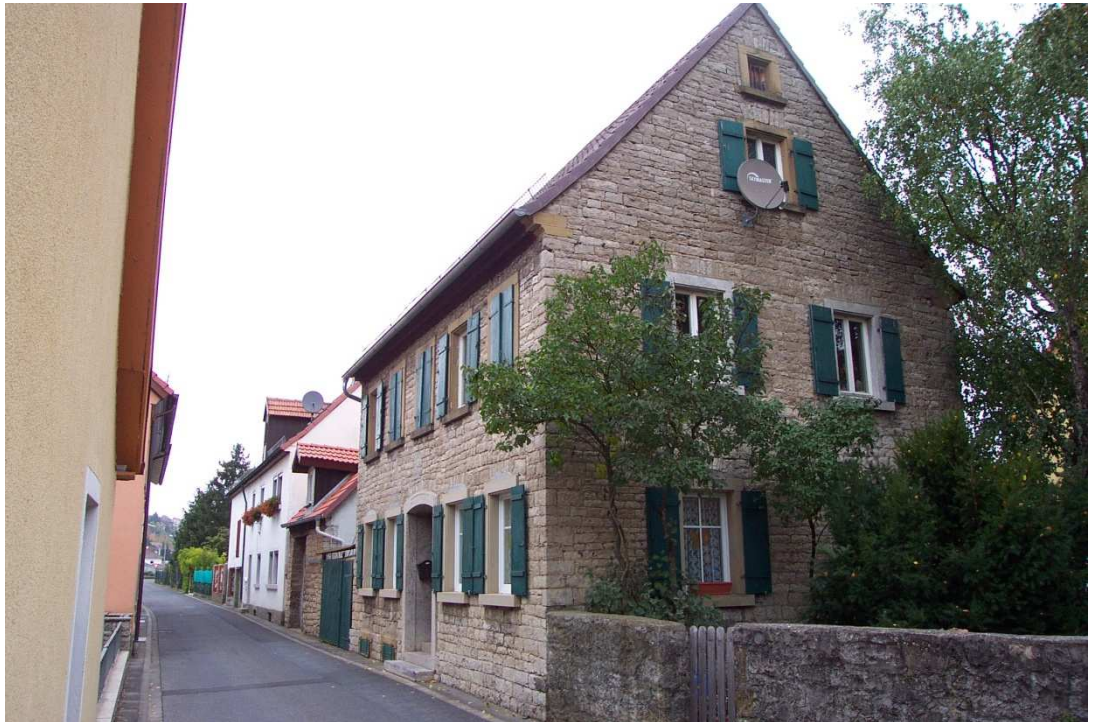
Muschelkalksichtmauerwerk Marterweg 2
