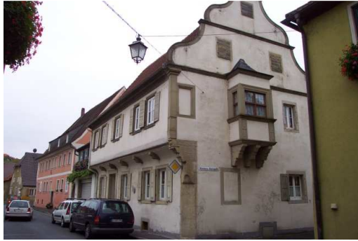
unregelmäßige Öffnungen Kirchstraße 3
