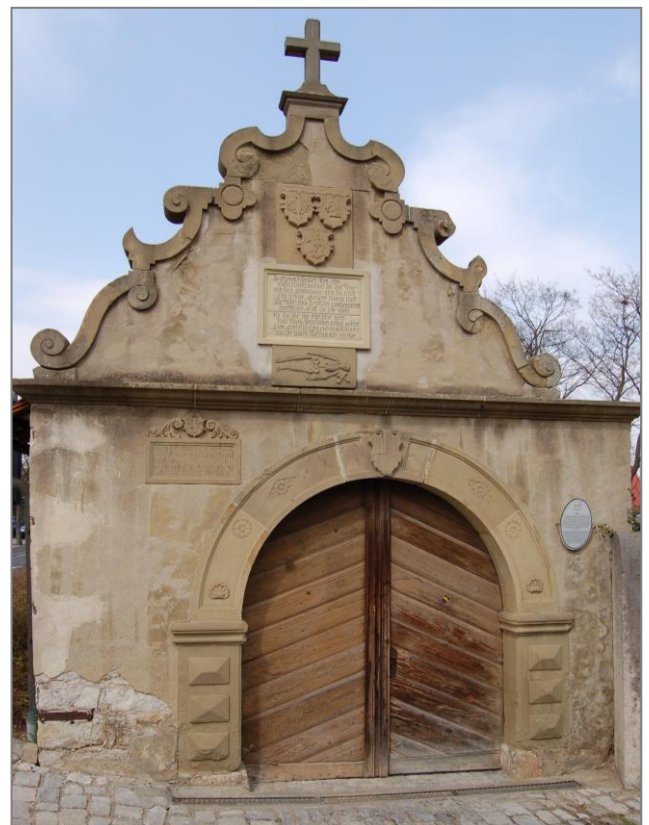
Das Portal im Jahr 2007 vor seiner Renovierung.
